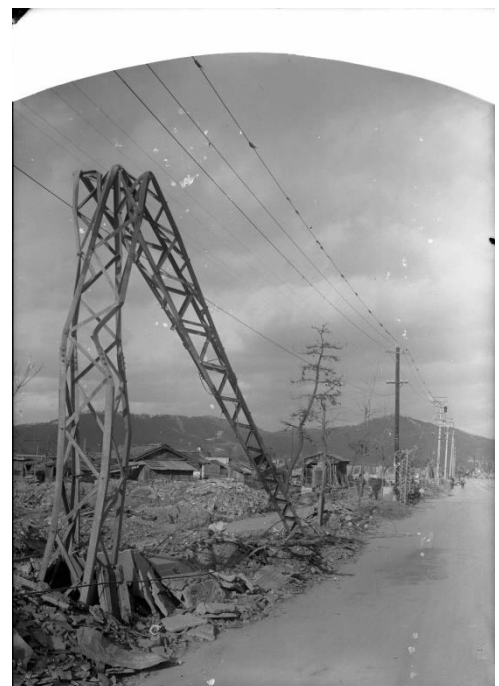
鉄柱連続倒壊状況(広島電鉄皆実線 沿い) 撮影：岸本吉太 提供：岸本坦
